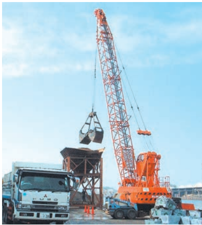
私有岸壁でのバラ貨物の荷揚げ作業
