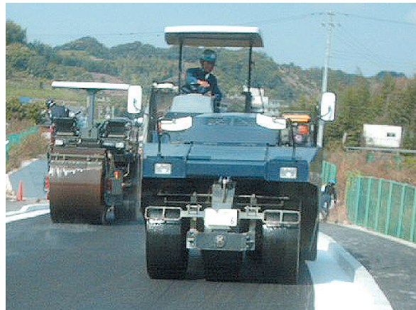
見た目にもこだわる道路舗装工事
