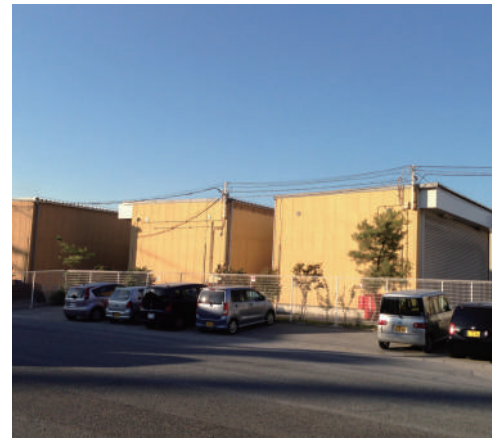
危険物倉庫3棟
