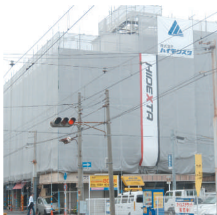
商業施設施工例
